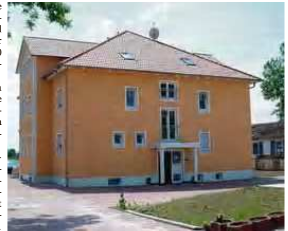
Das neue Bürohaus der Union Finanzservice im Schleifmühlweg ist gut erreichbar und bietet ausreichend Parkplätze für Kunden.
